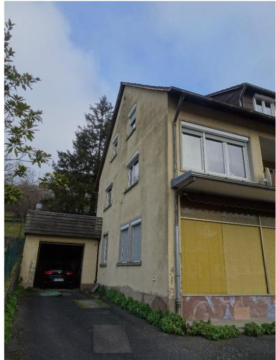
Am östlichen Giebel befinden sich noch Fensterläden (Lamellen), an den Fenstern der anderen Seiten, z.B. am westlichen Giebel, wurden Vorbau-Rollos aus Aluminium angebracht.
